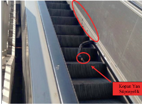
Resim 16. Metal Fırçadan Kaynaklı Meydana Gelen Kaza
