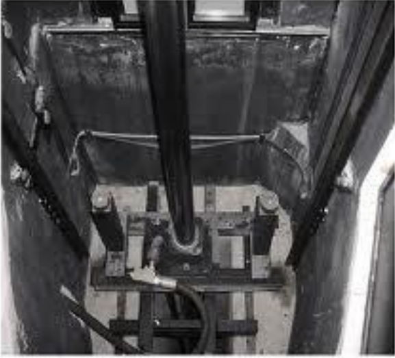
Resim 5.13: Merkezden tahrikli hidrolik asansörün kaynağına girintisi
