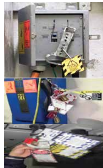
Resim 20- Örnek Etiketleme-Kilitleme Sistemleri
